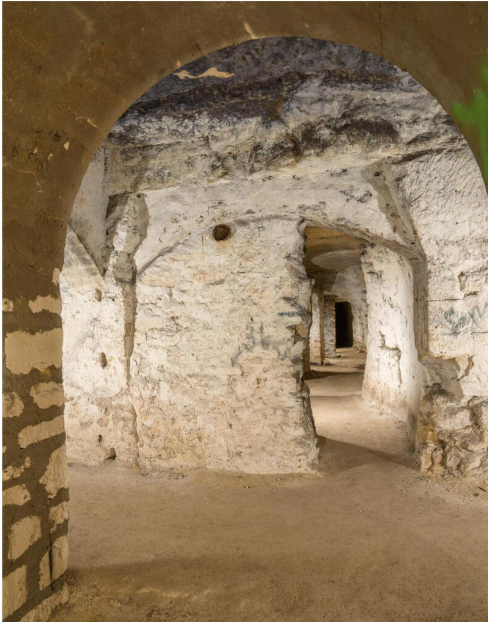
Entrée d'une des caves murée par l'occupant allemand durant la Seconde Guerre Mondiale, rouverte à la libération. Le tuyau de ventilation et la maçonnerie en béton de ciment est caractéristique des fortifications militaires de cette période. L'ensemble a été recouvert de lait de chaux par les champignonnistes occupant le site a posteriori. Les différentes caves étaient louées à des viticulteurs et négociants de vin de Bourgogne.
