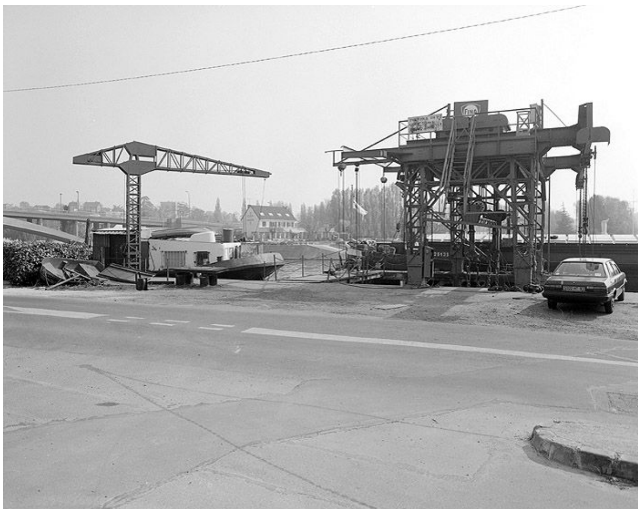
Vue générale du dispositif de réparation avec la grue et le portique.
