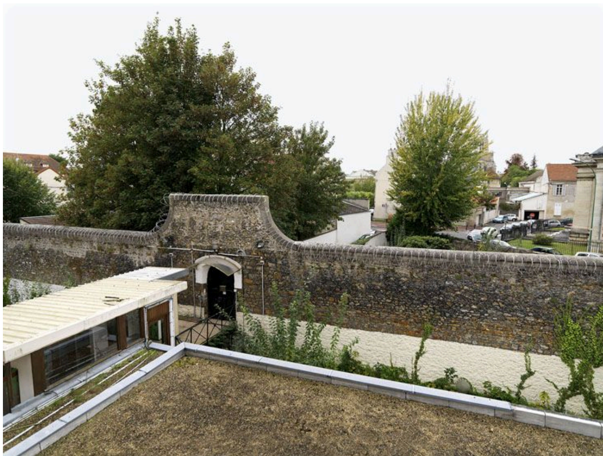
Le mur d'enceinte de la maison d'arrêt et son portail, vus depuis les bâtiments de l'administration.
