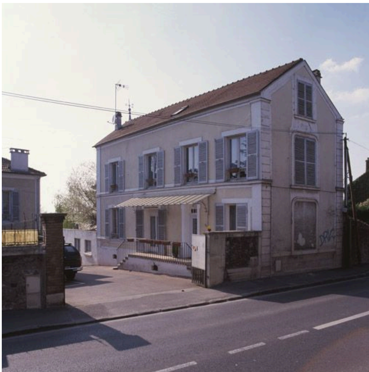
Vue d'ensemble de la maison, 27 boulevard Henri-Barbusse.
