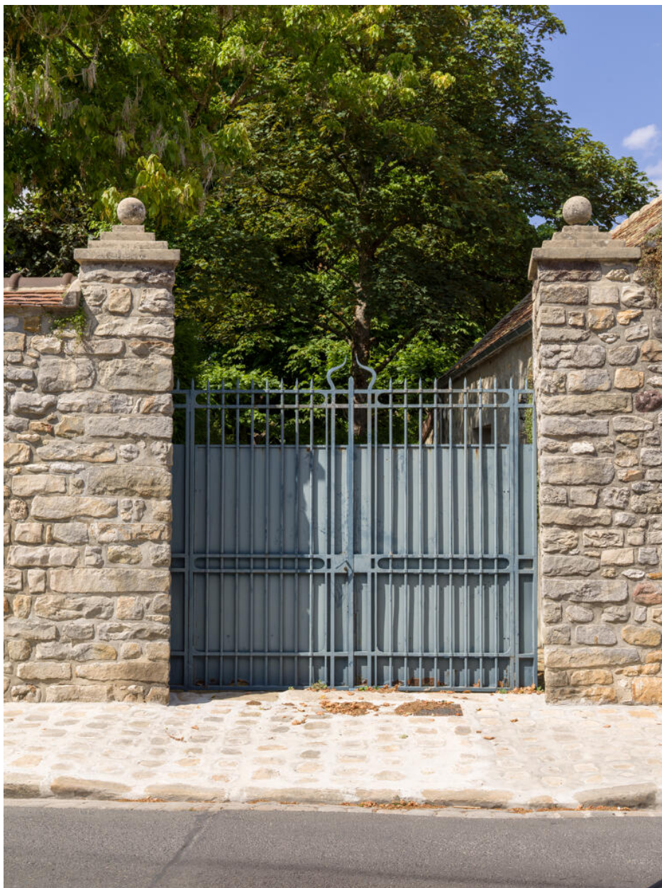
Portail d'entrée du parc du 71 rue Langlois (ou 1 rue Charles Cochin), vue depuis le sud.
