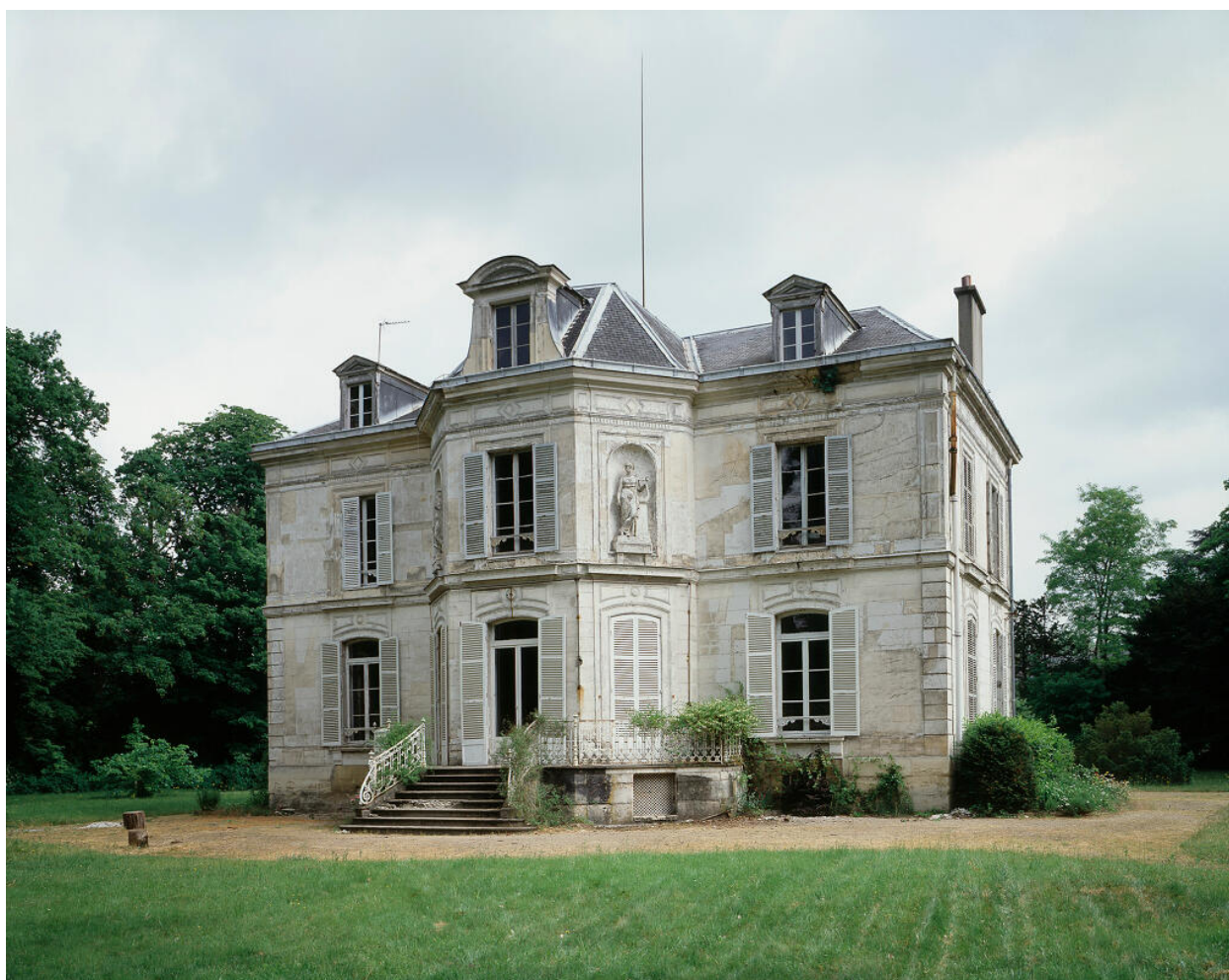
Vue d'ensemble de la façade postérieure.
