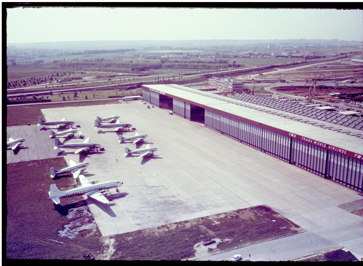
1960, zone industrielle nord de l'aéroport d'Orly, le hangar N6 vu depuis le sud est.
