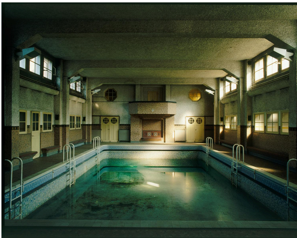
Bâtiment de la piscine-gymnase. Vue intérieure de la piscine vers l'entrée et la tribune.. groupe scolaire de la cité jardin, actuellement Henri Sellier
