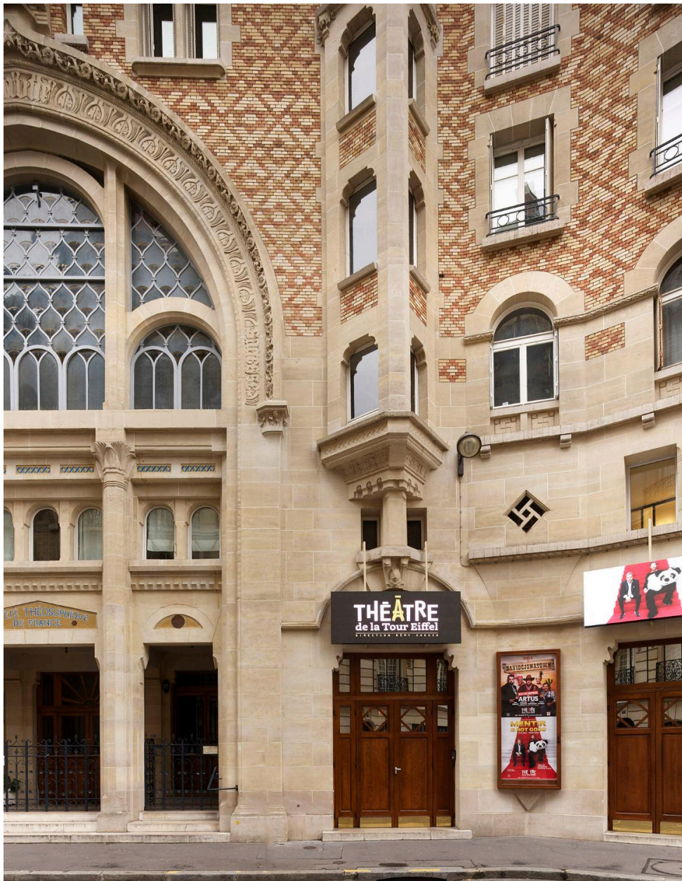
Façade, entrée de la salle Adyar et oriel surmontant celle-ci
