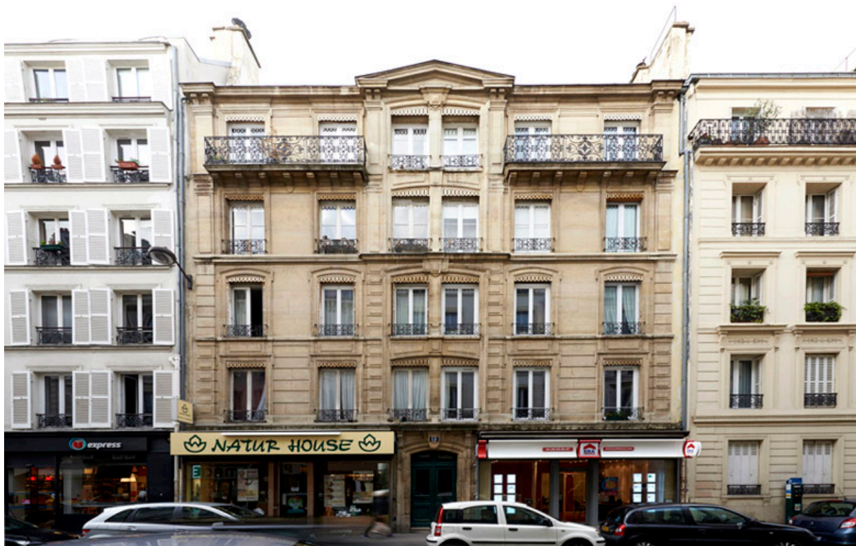
Façade de l'immeuble.
