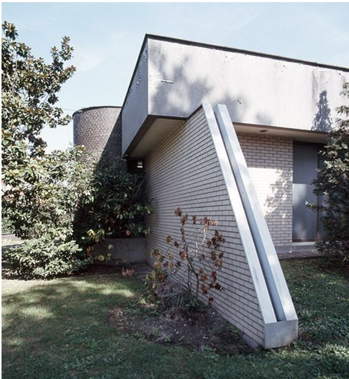
Détail de l'imbrication des volumes d'une maison, 158-162 rue de Metz.
