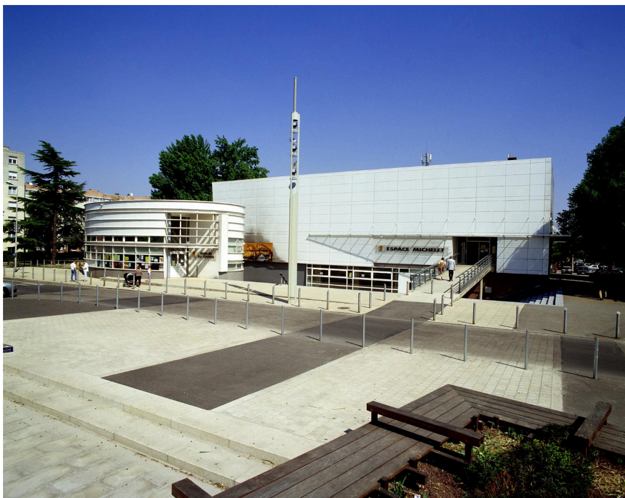
Vue de l'Espace Michelet (ancienne église Notre-Dame-de-l'Air) et de la Maison du Citoyen à l'extrémité de la place Mendès-France.
