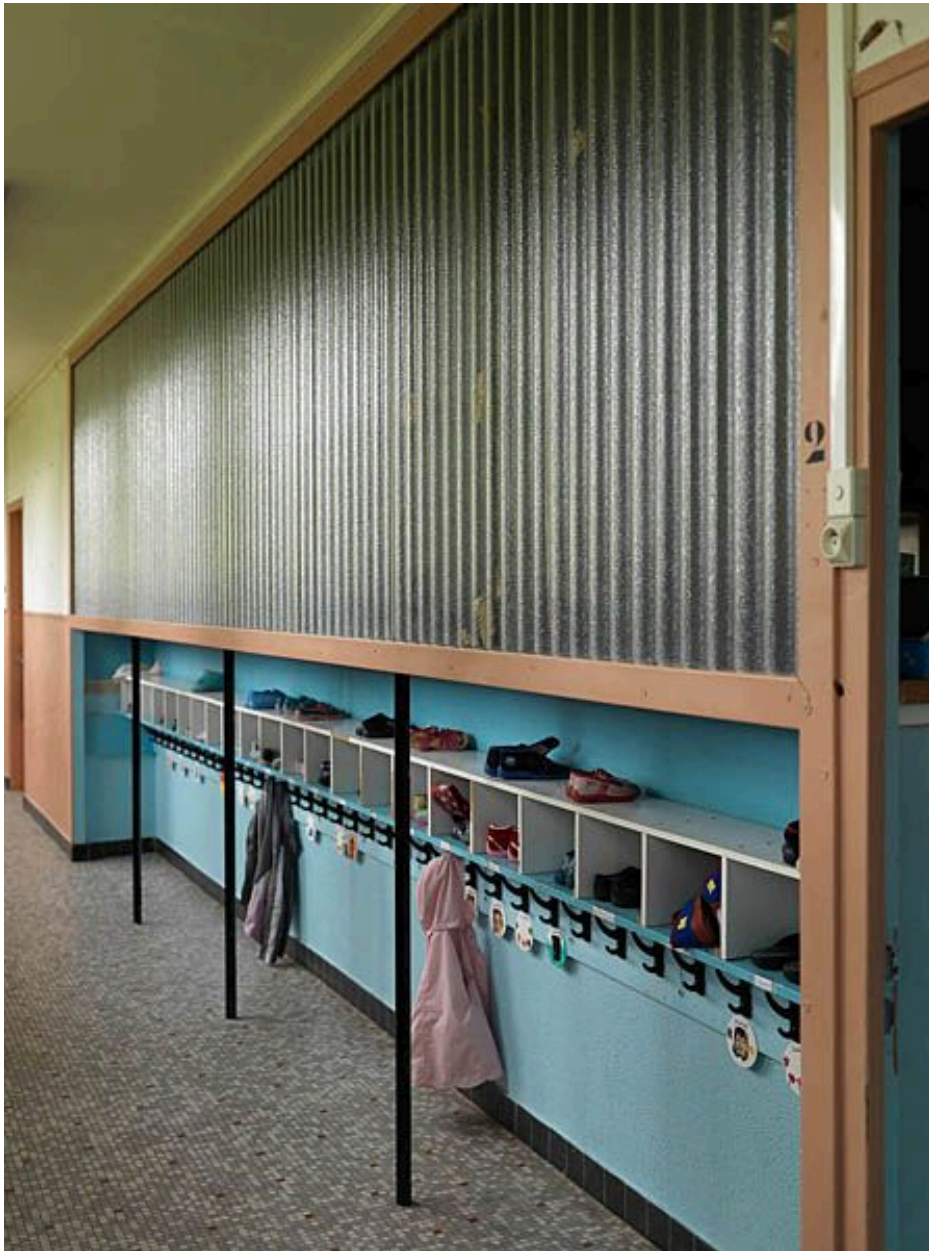
L'école du Pierris, 10 rue Guillaume-Briçonnet (actuellement centre aéré). Cloison en verre ondulé granulé, casier et porte-manteaux.
