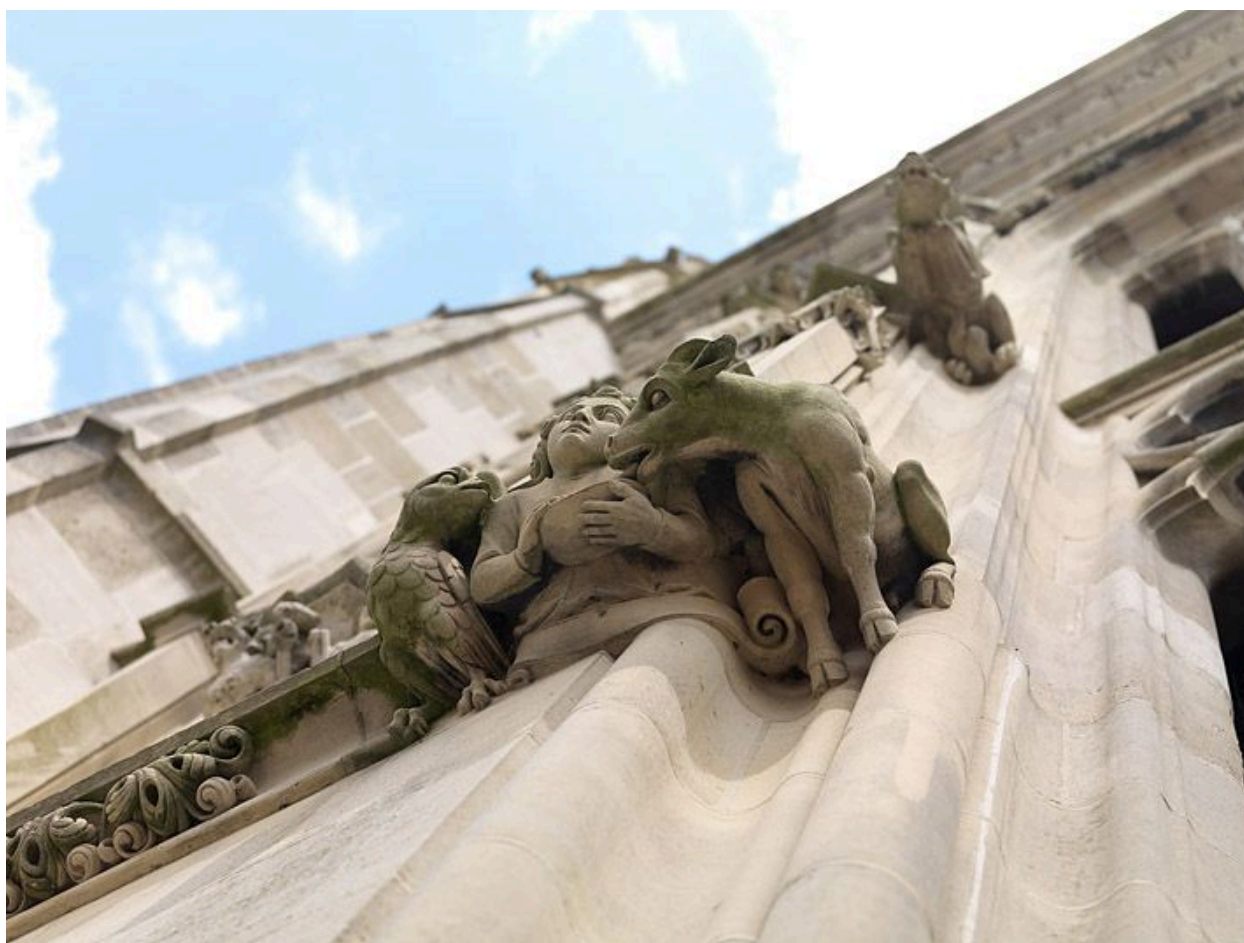
Tour nord, 3e niveau, élévation sud : détail de corniche.
