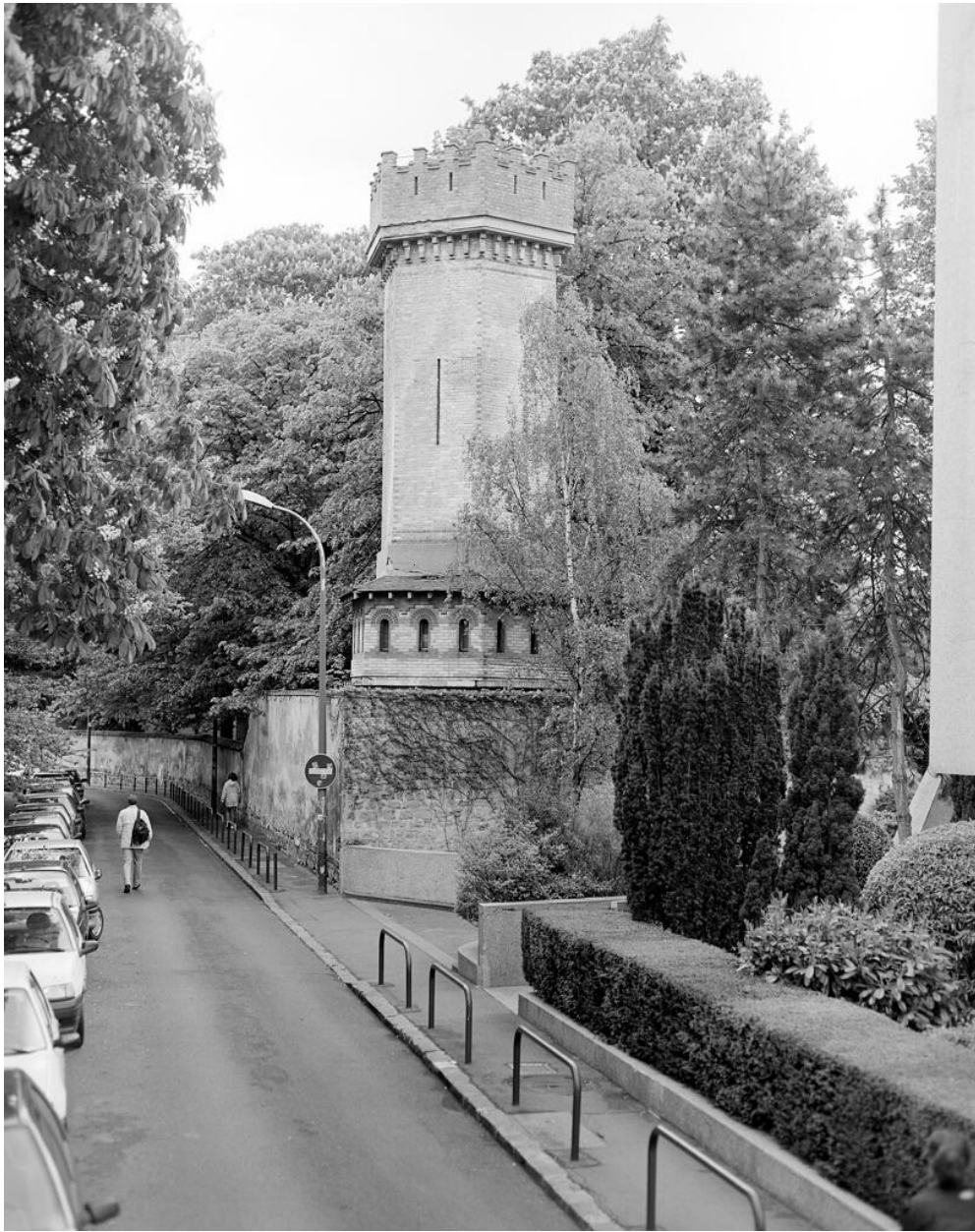
Tour d'eau de l'ancien Castel Gamio conservée par le docteur Debat dans le jardin de la villa des Tourneroches
