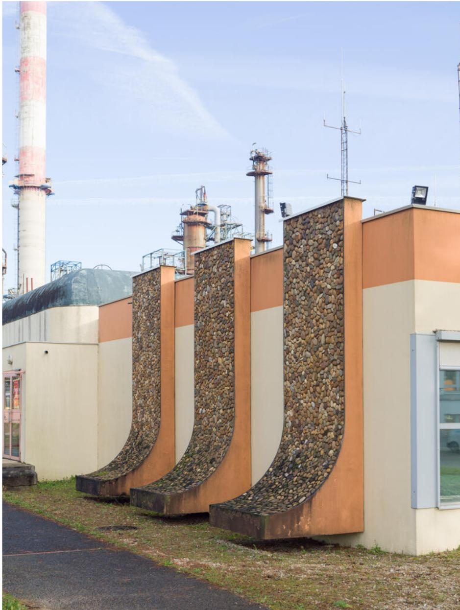
Flanc ouest du bâtiment salle de contrôle : services supports rattachés à l'exploitation. Les "virgules" en béton armé, datant de 1979, sont progressivement supprimées depuis les années 2000 en raison de leur instabilité potentielle en cas d'explosion.
