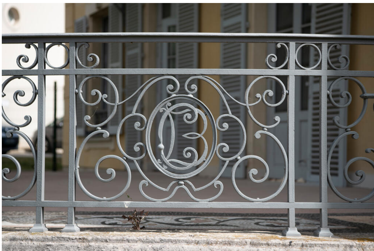
Détail du garde-corps de la terrasse.
