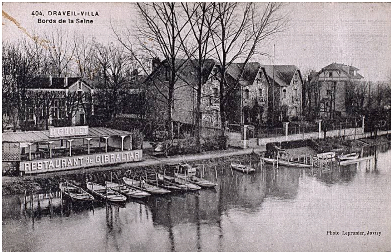
Villas en bord de Seine, le long du quai des Dames, et terrasse du restaurant de Gibraltar. Carte postale, vers 1910. (AD Essonne, 2 Fi 63)
