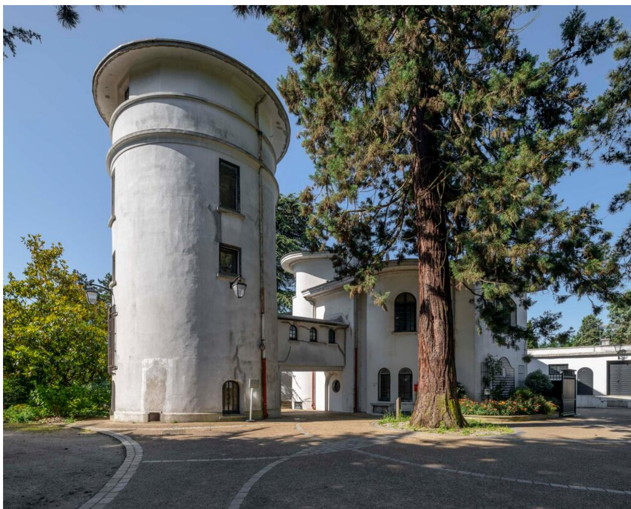
La façade nord.
