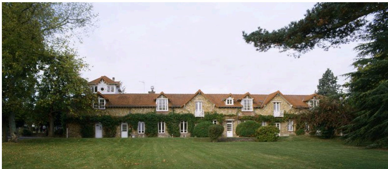
Ancien bâtiment de la ferme-école transformé en internat : vue d'ensemble.
