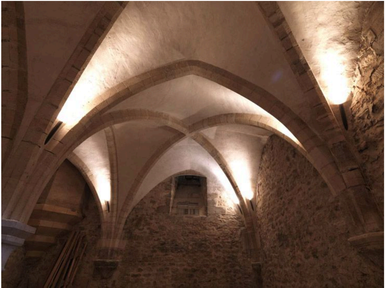
La salle voûtée du sous-sol : le voûtement (travée de l'angle sud-ouest).
