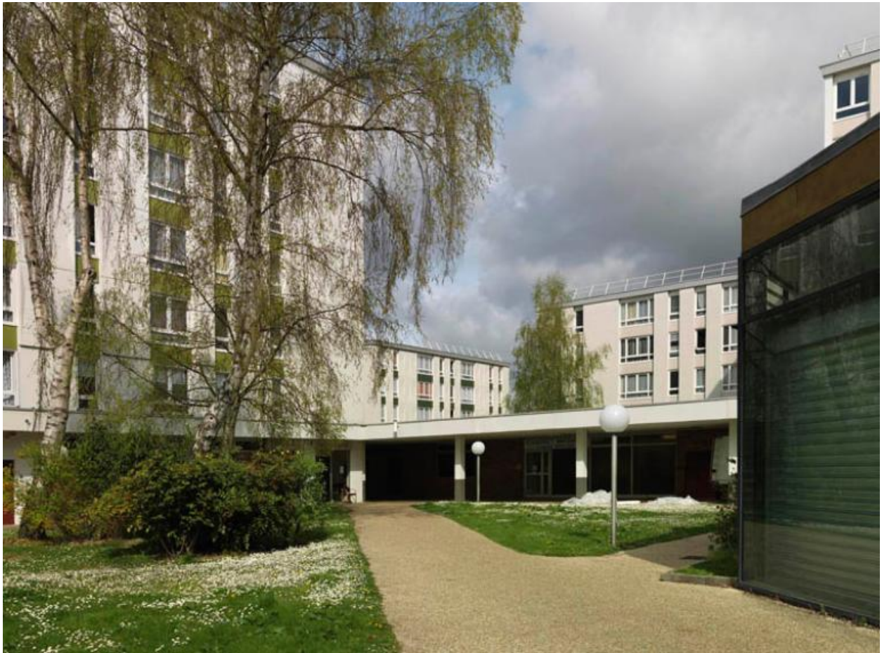
Le patio intérieur du centre commercial.
