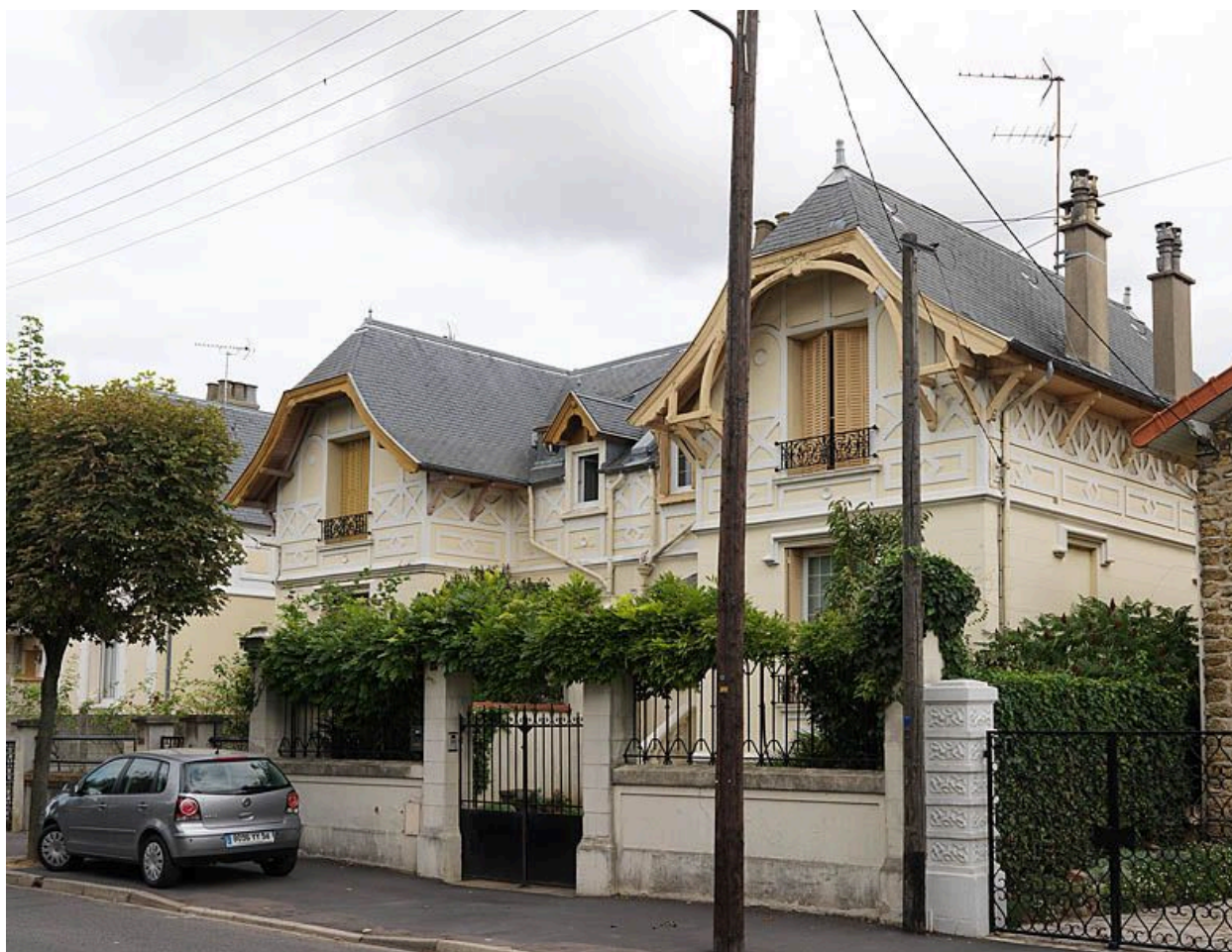
Villeneuve-le-Roi, maison en série (série de 4), 28, 30 avenue Henri Gilbert. Vue générale.
