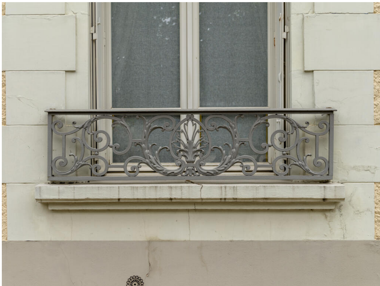
Garde-corps d'une baie de la façade sur rue.
