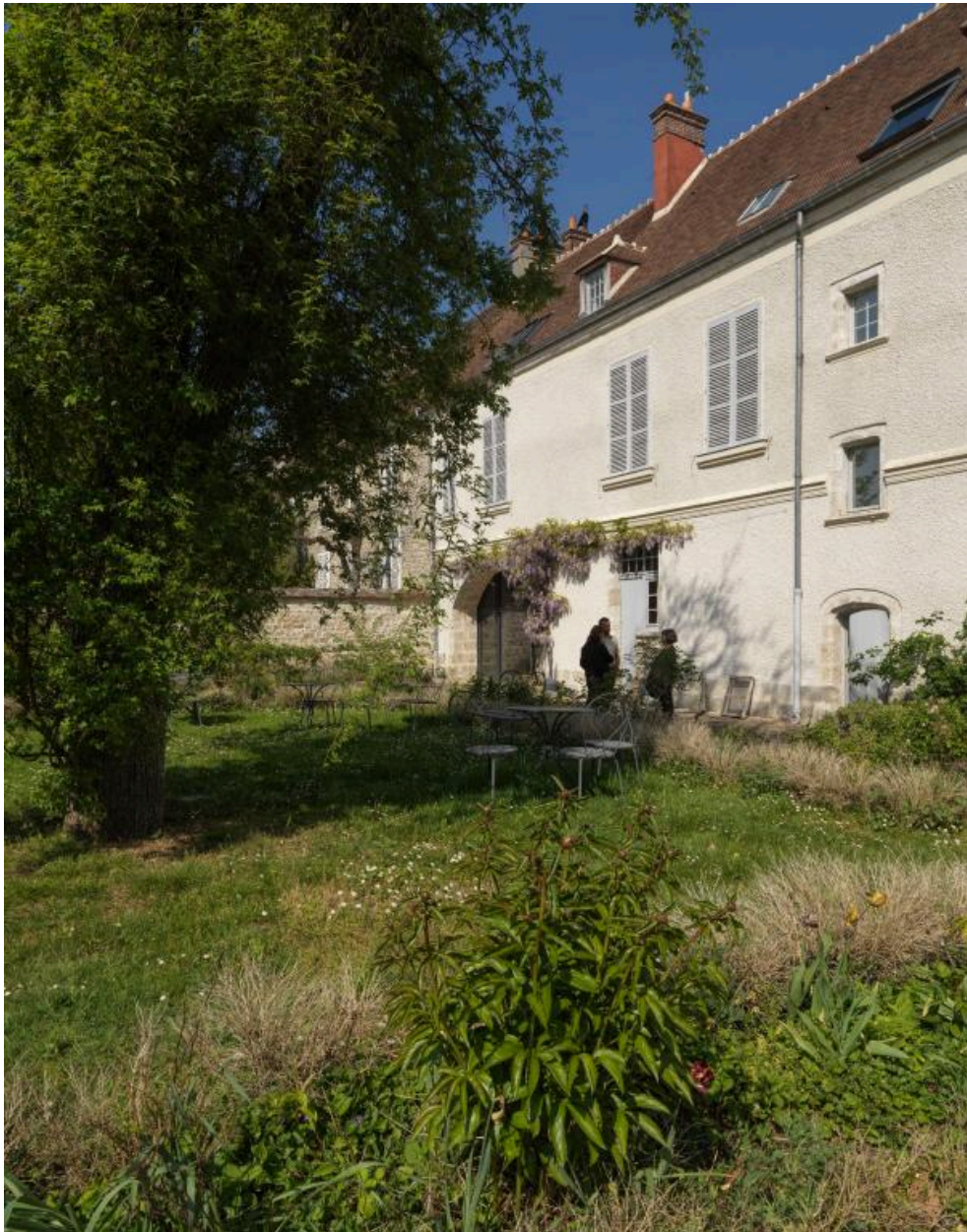
Vue de la façade postérieure du bâtiment principal (6)
