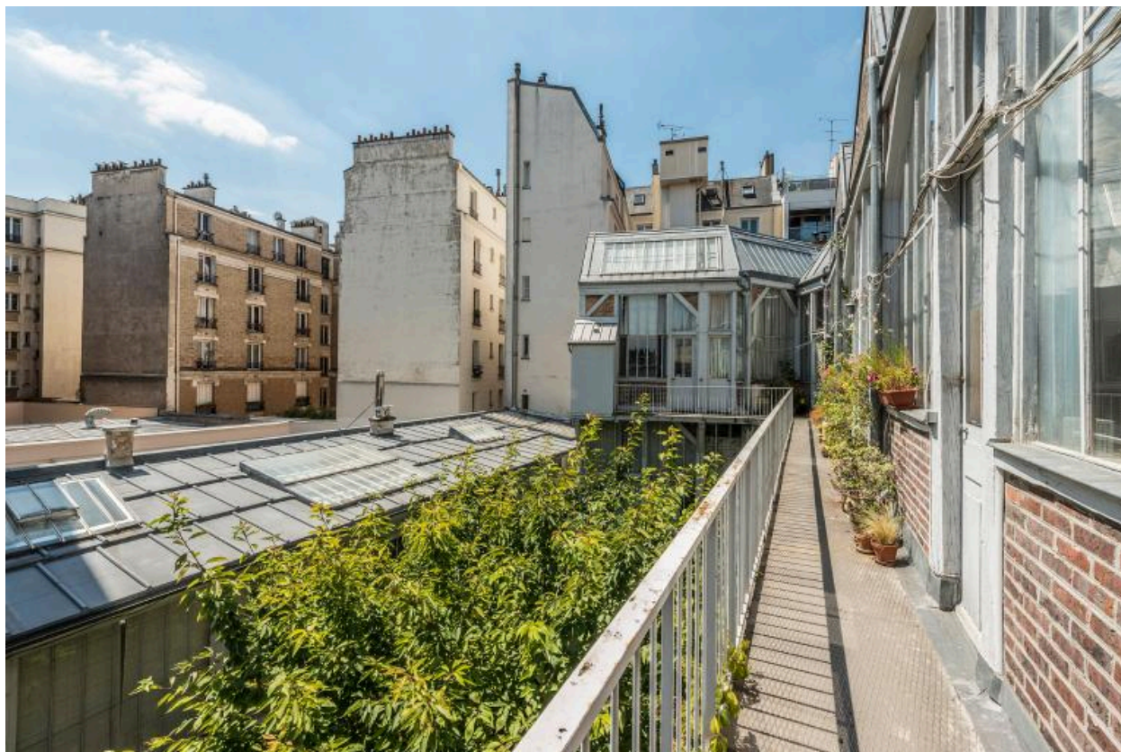
Vue des ateliers en mezzanine (4)
