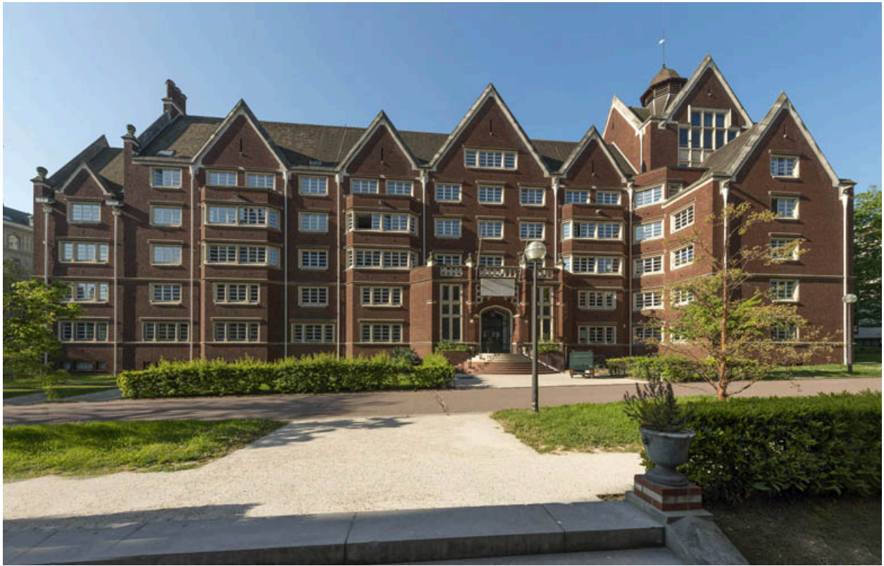
Vue d'ensemble de la façade nord.
