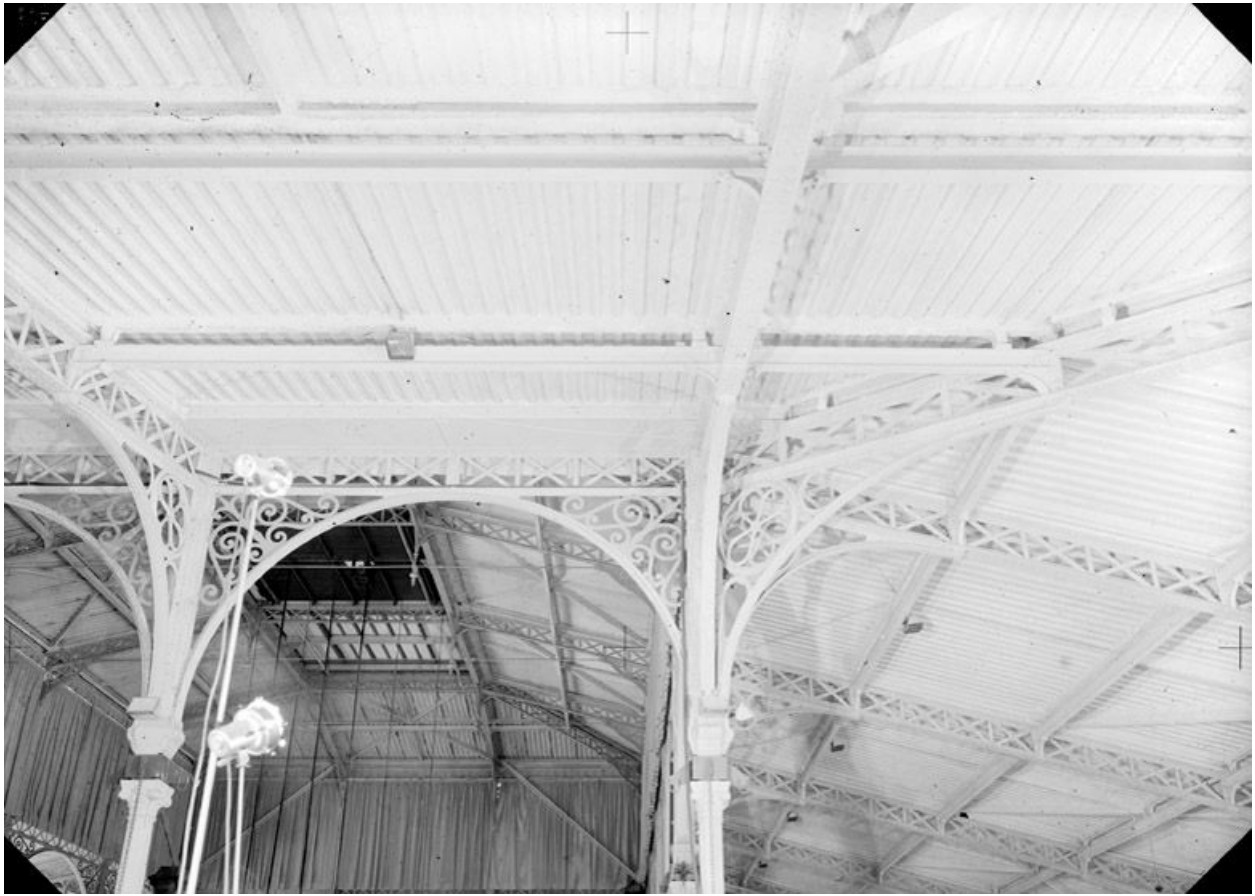
Jonction entre les arcades et les fermes transversales. Couple photogrammétrique.
