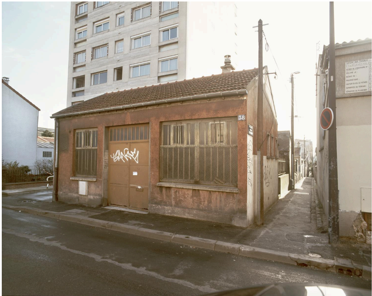
Vue de l'atelier depuis la rue de Romainville.
