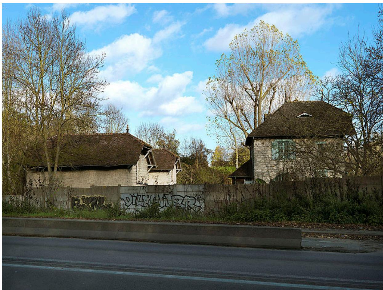
Le pavillon du gardien, à l'entrée du site de Torcy : vue prise depuis le sud-ouest, de la route de Torcy.
