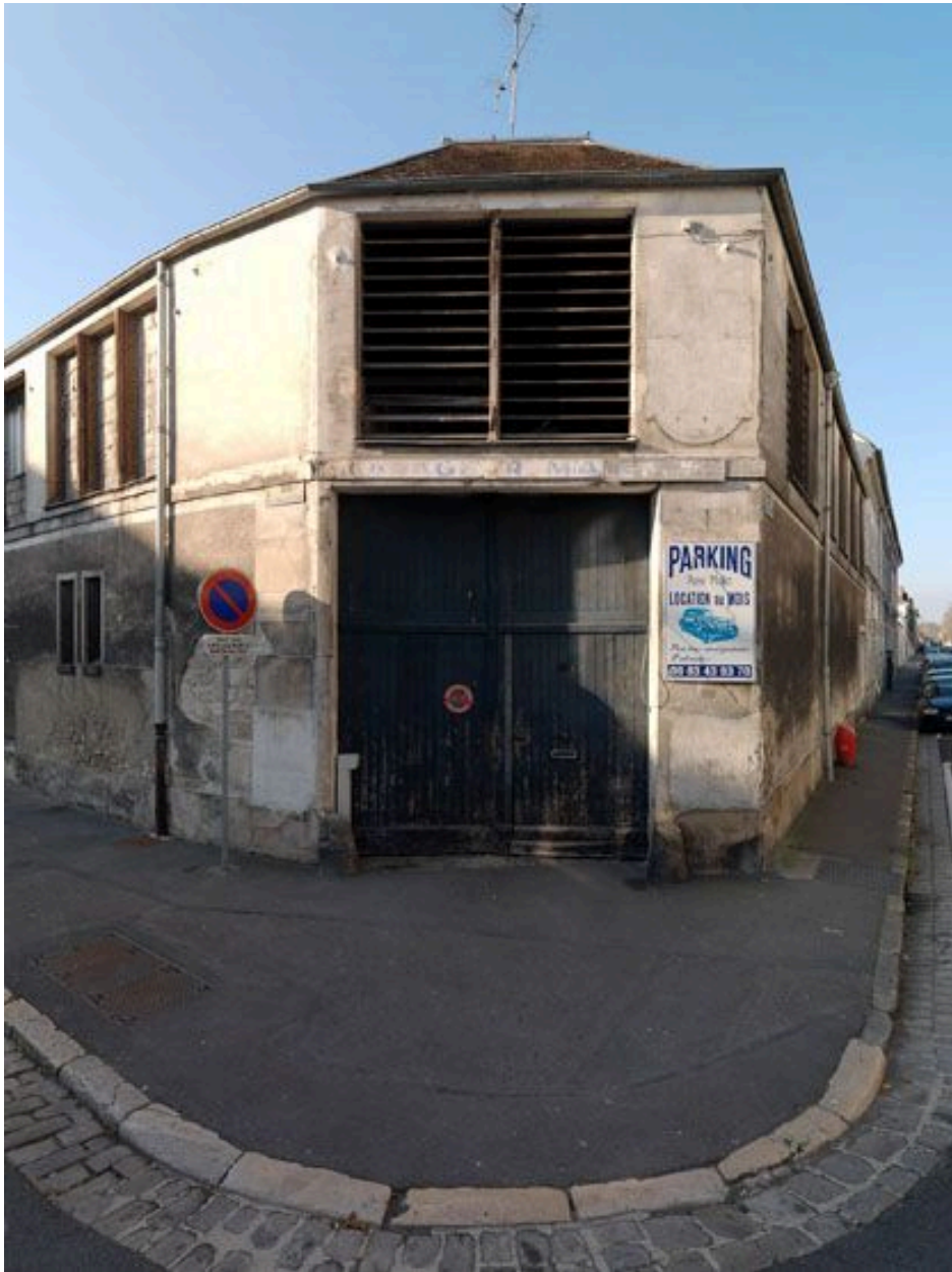
Vue de détail de l'entrée surmontée d'une ouverture possédant encore le système d'abat-vent en bois de l'ancienne blanchisserie.
