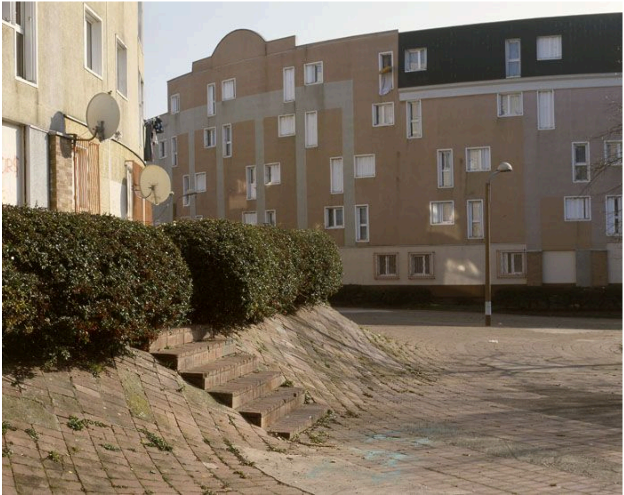
La Noé. Vue actuelle de la place des Quatre-Vents. Détail du traitement du sol de briques remontant vers les bâtiments. Des marches dans les talus donnent accès aux immeubles.
