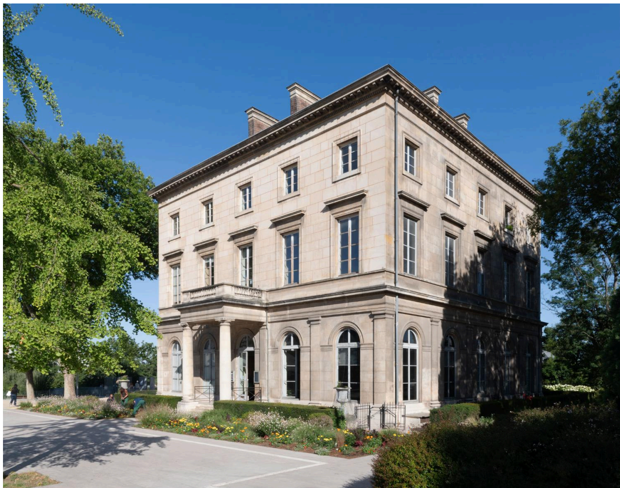
Façade principale et façade latérale est
