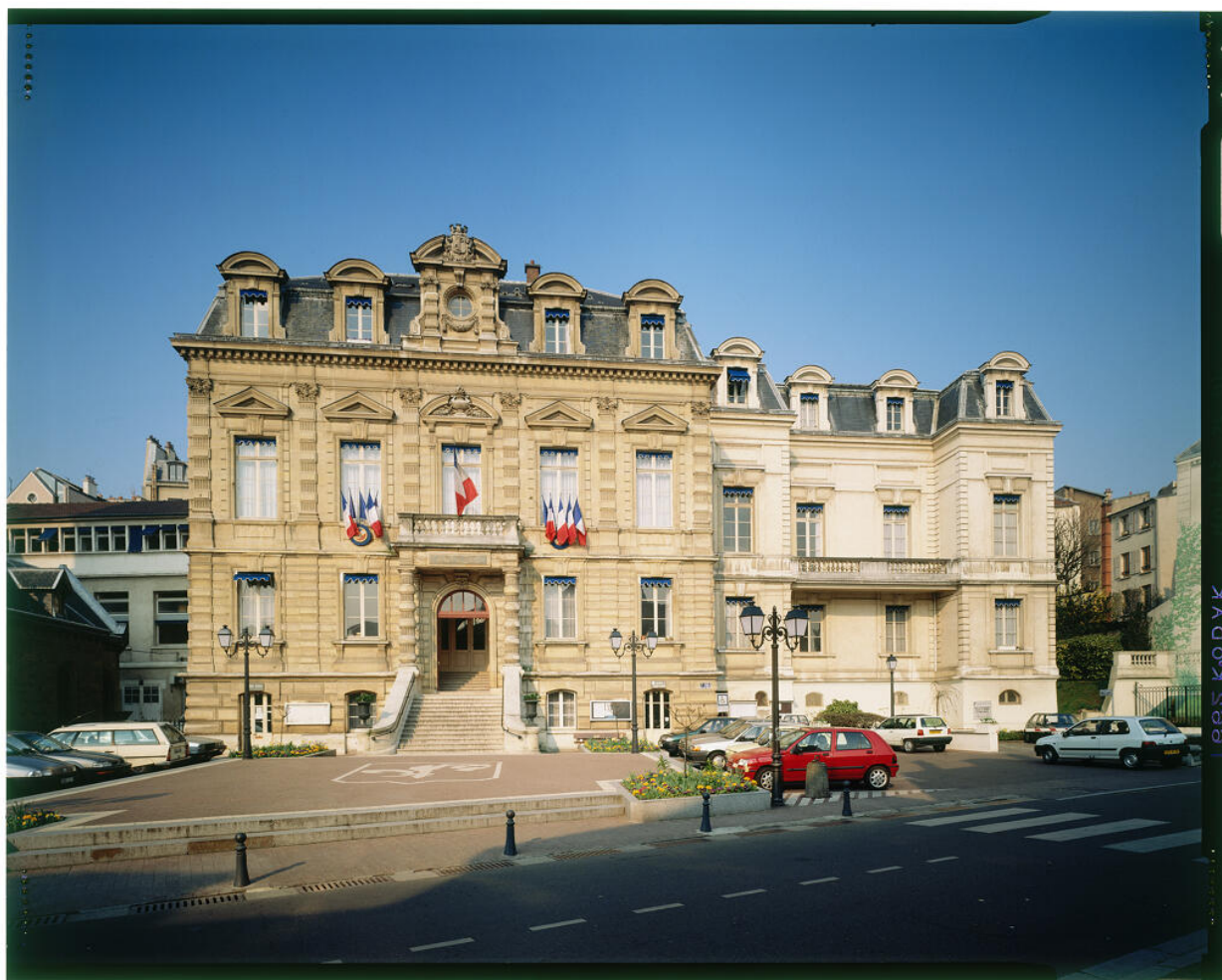
Mairie de Saint-Cloud, façade principale
