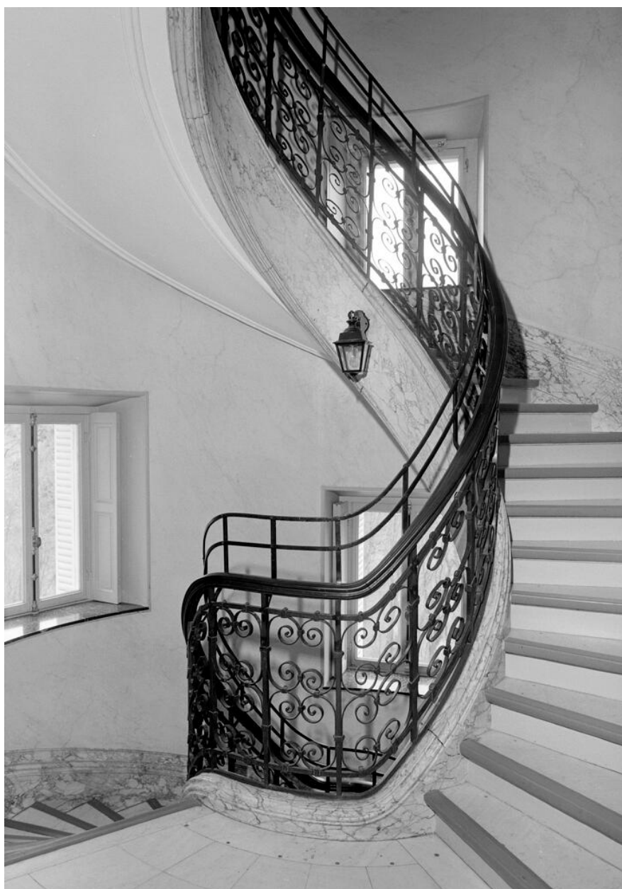
Détail de la rampe de l'escalier principal.
