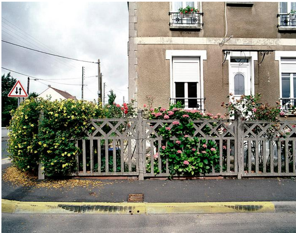
Clôture en ciment armé.
