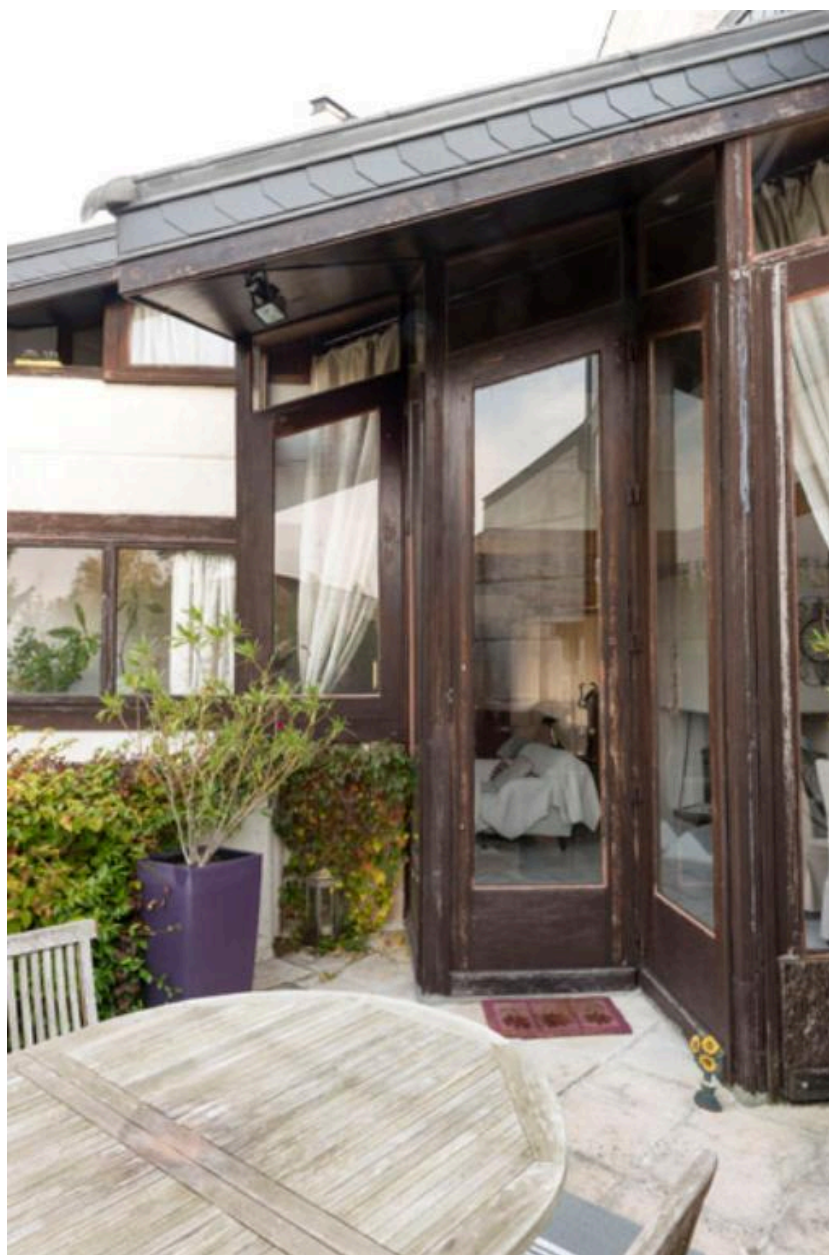
Détail de la façade coté jardin.
