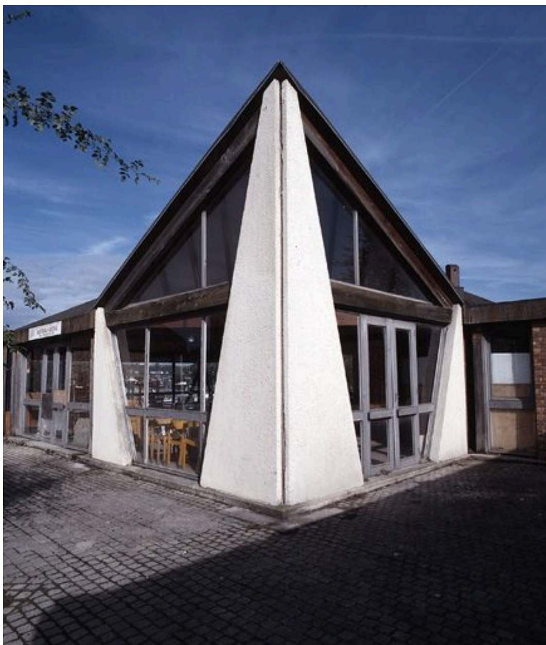
Détail d'un des bâtiments situés près de l'entrée du port.
