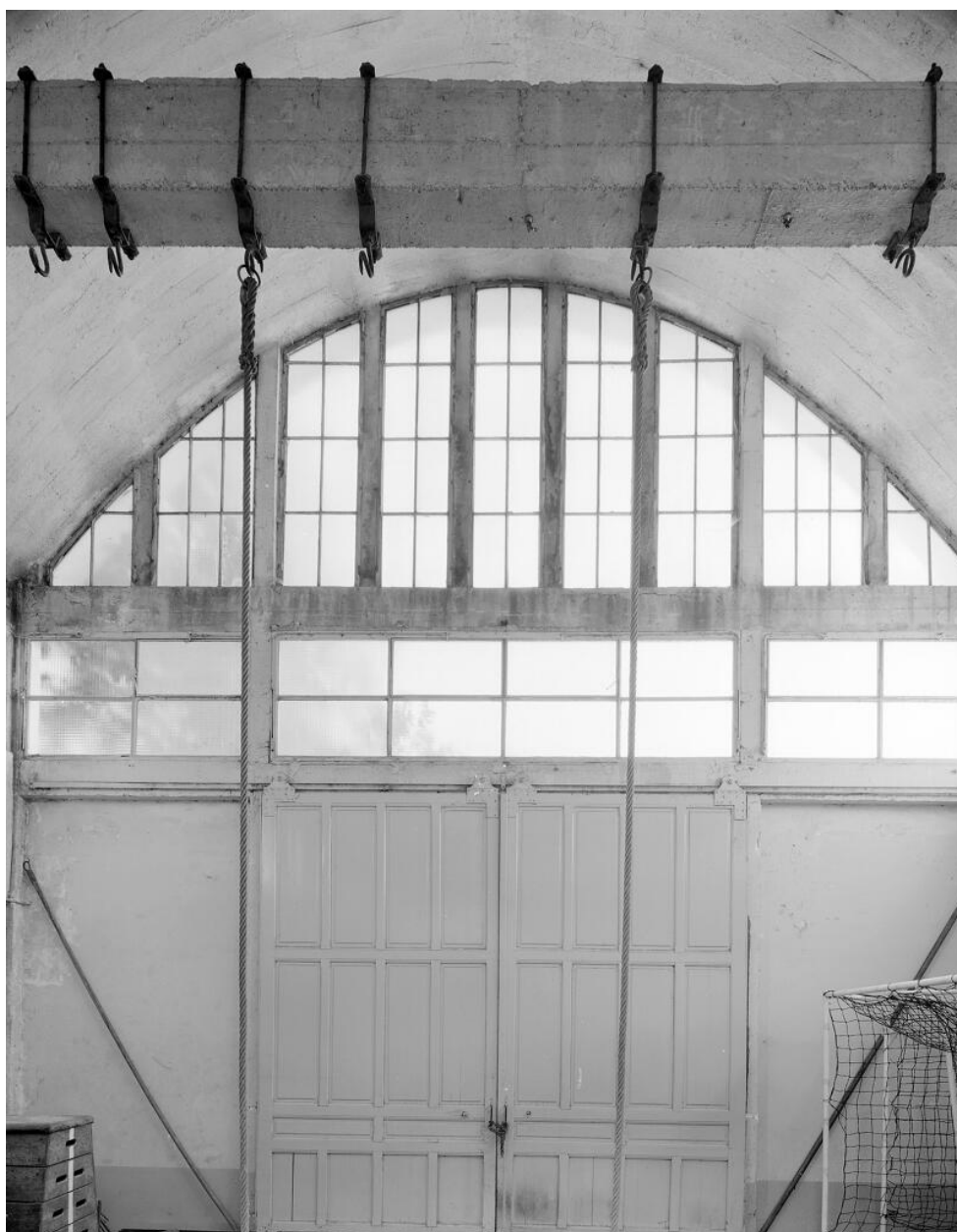
Vue intérieure de la salle d'agrès du gymnase. Stade Jack-Baudequin
