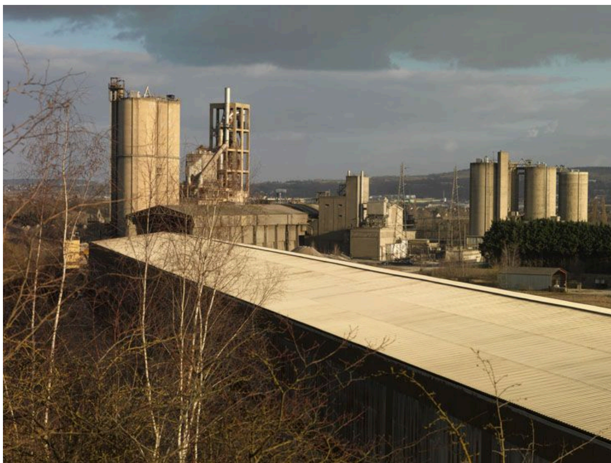
Gargenville ; Juziers, cimenterie Poliet et Chausson; puis Société des ciments français, puis Ciments Calcia, Victor Hugo (avenue). Vue des Fours.
