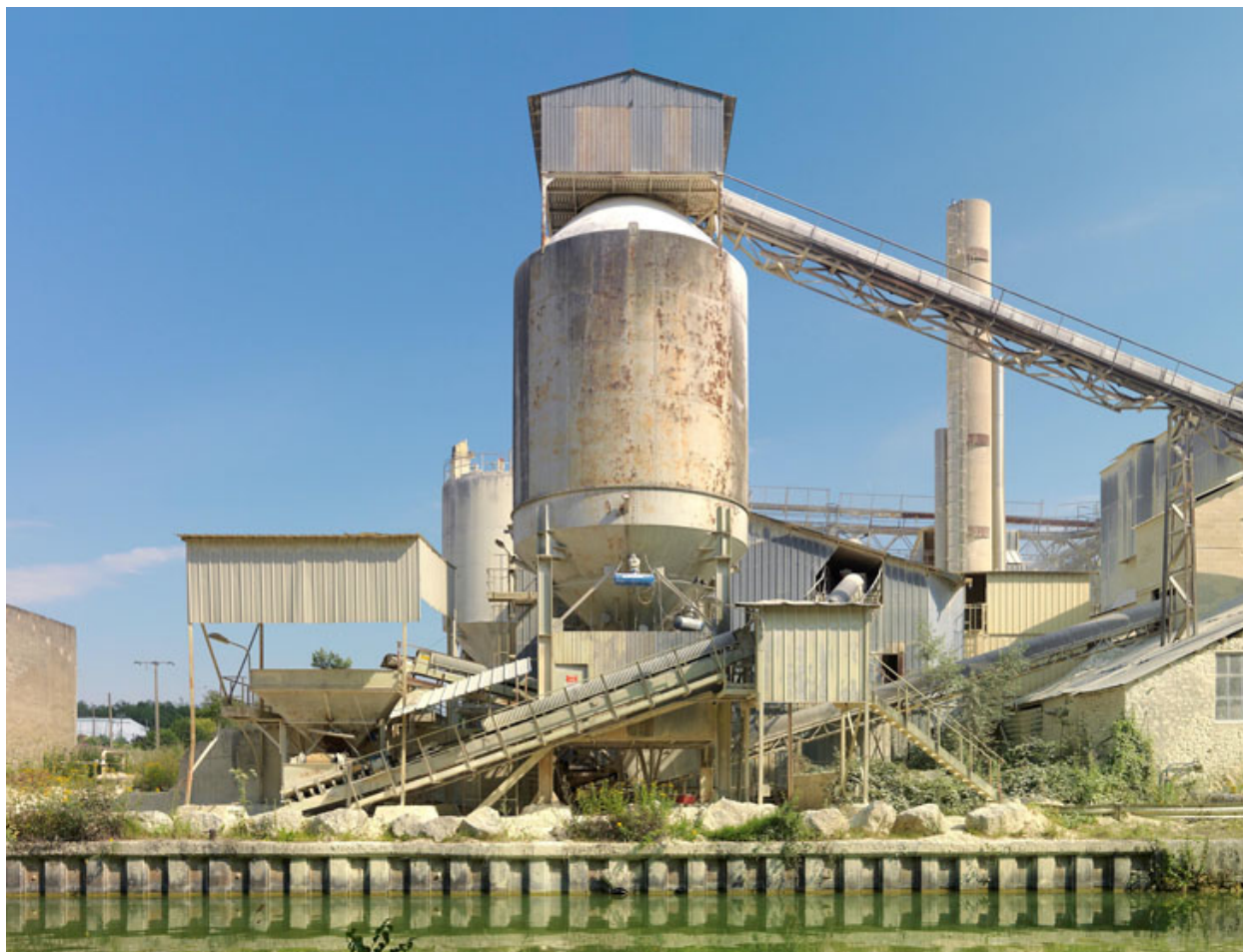
Vue extérieure depuis le canal du Loing.
