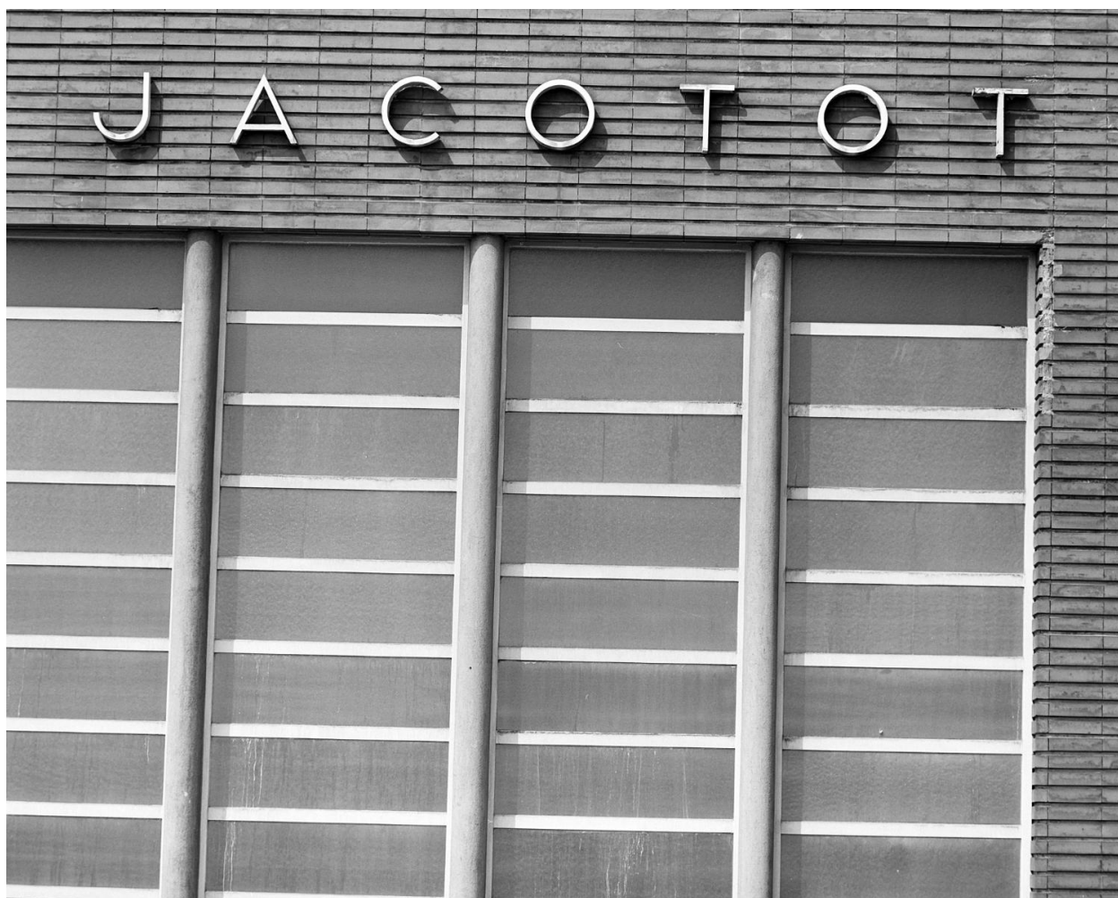
Piscine. Détail de la façade.. Ecole maternelle, école primaire de garçons, école primaire de filles dites groupe scolaire Marius Jacotot
