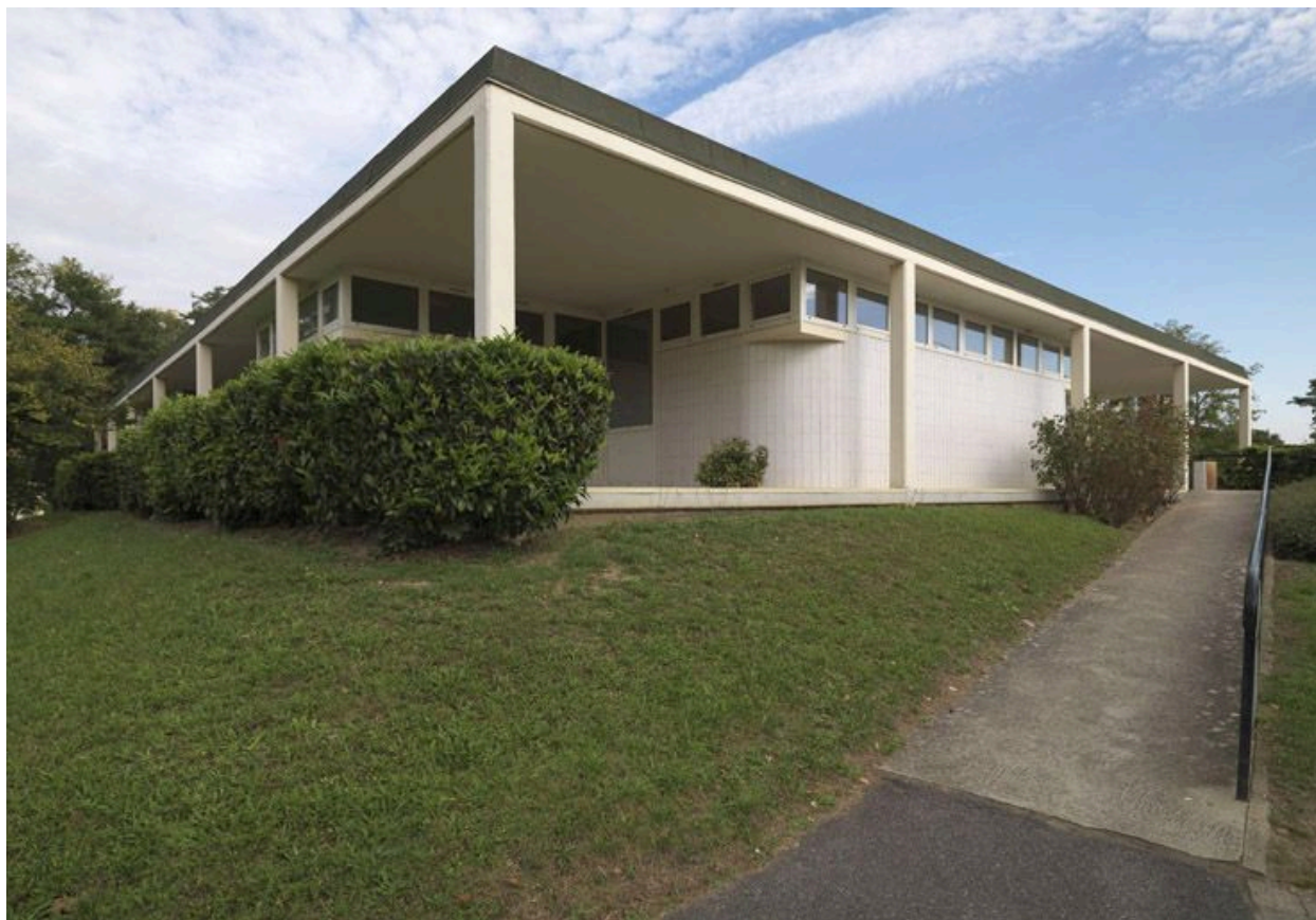
Façades arrière et latérale du bâtiment.
