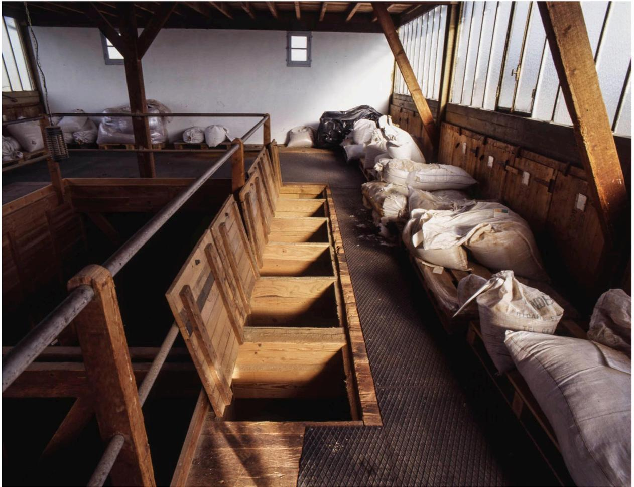
5ème étage du bâtiment principal. Vue rapprochée des trappes de remplissages des silos de stockage.
