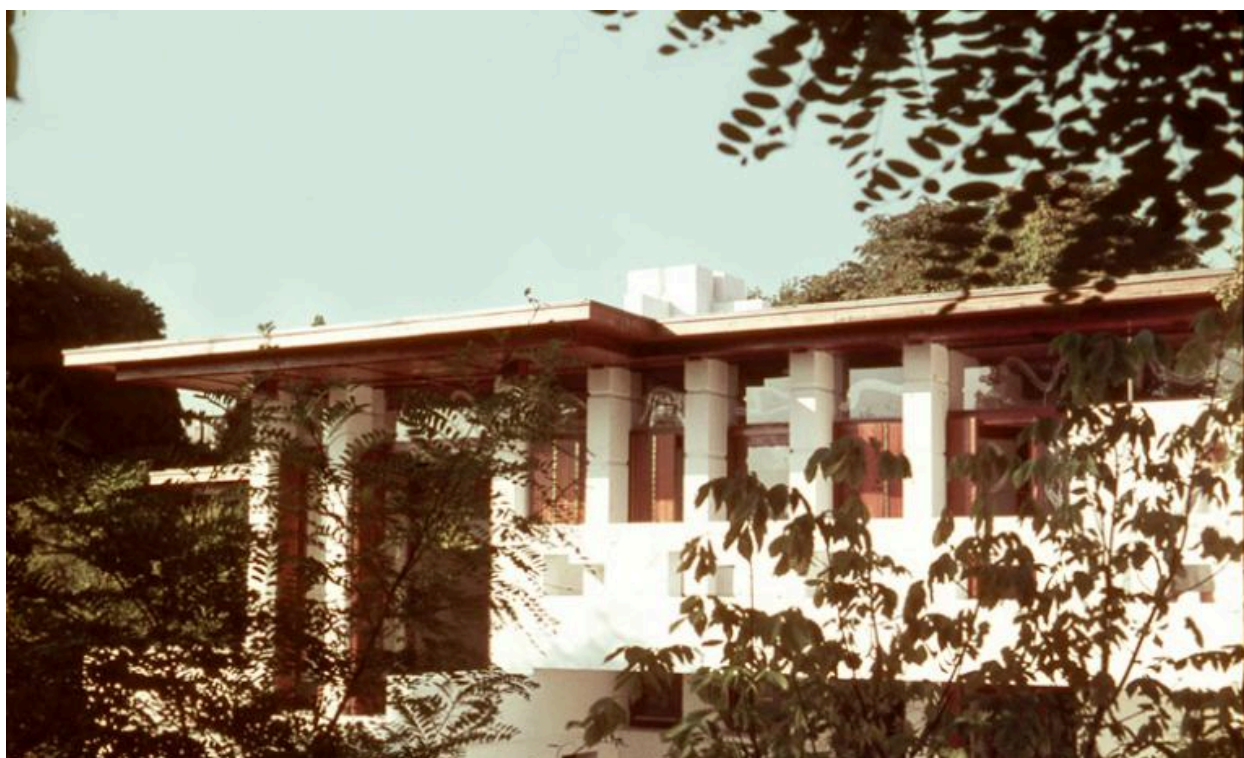
Vue ancienne de la façade côté jardin.
