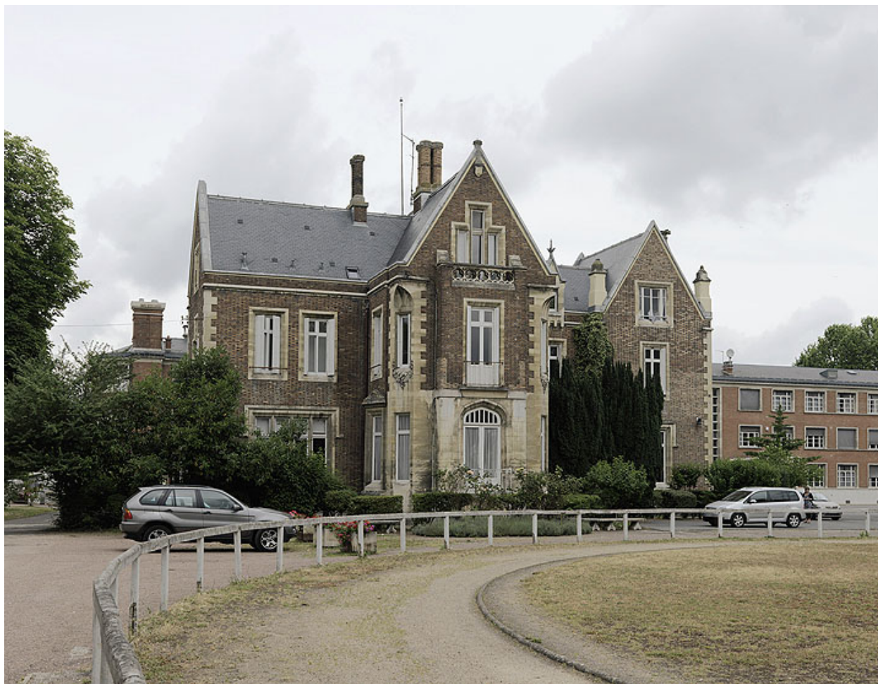
Vue de la façade donnant vers le lac.
