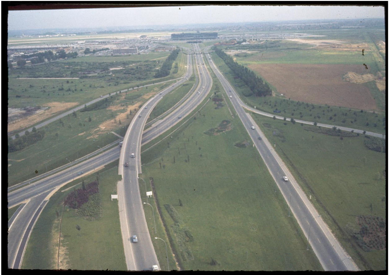
1962, les Installations Terminales vues depuis le nord.
