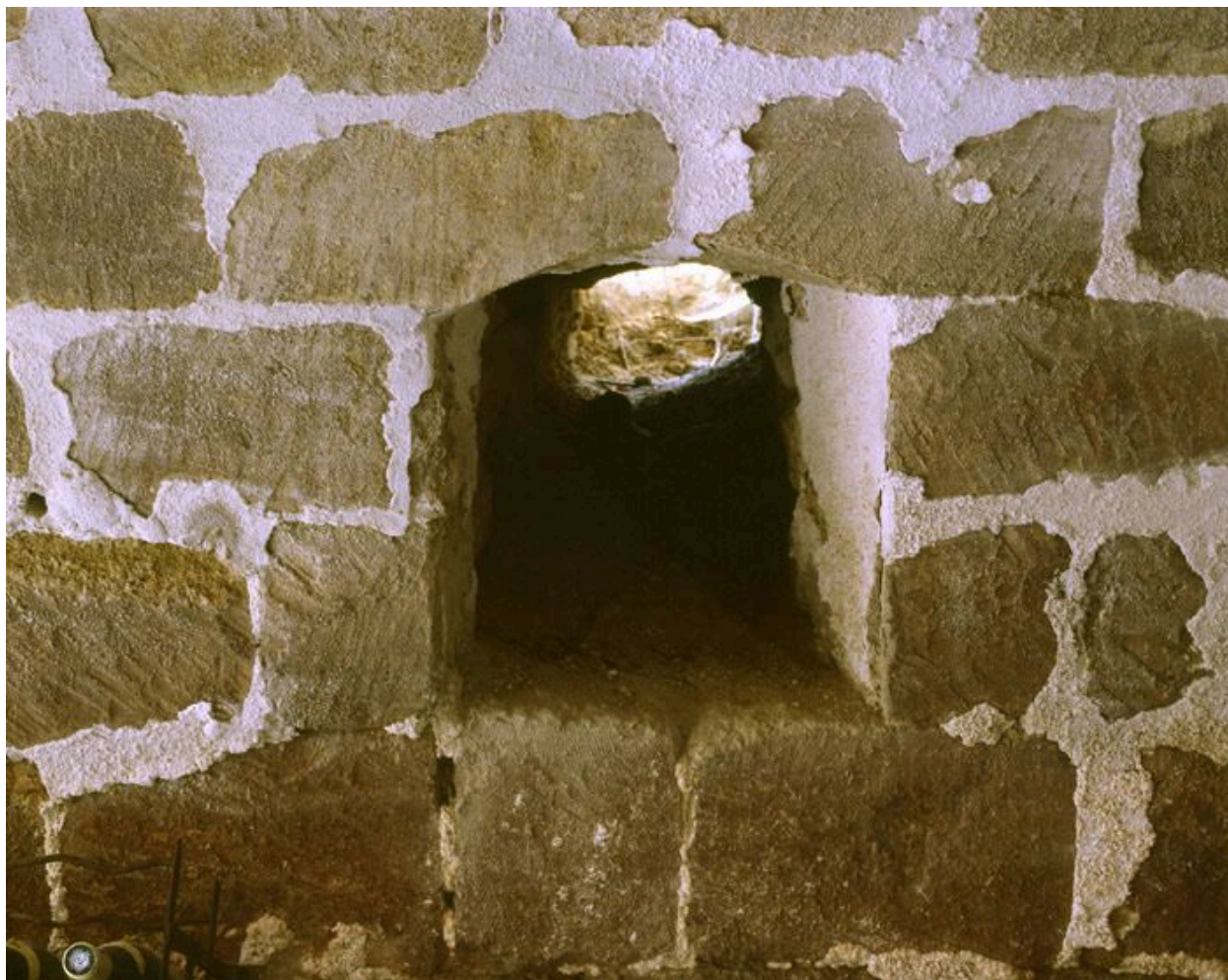
La cave : détail d'un sopirail.
