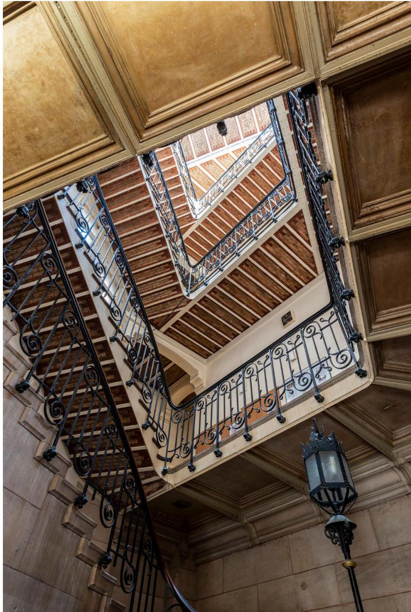
A la fin du XIXe siècle, l'architecture des lycées s'empare des techniques innovantes mises à l'œuvre simultanément dans les programmes tels que les grands magasins, les gares, les marchés. Le fer et la brique se laissent ainsi entrevoir dans les parties les plus fonctionnelles, comme ici dans la cage de l'escalier principal du lycée Racine (Paris, 8e).
