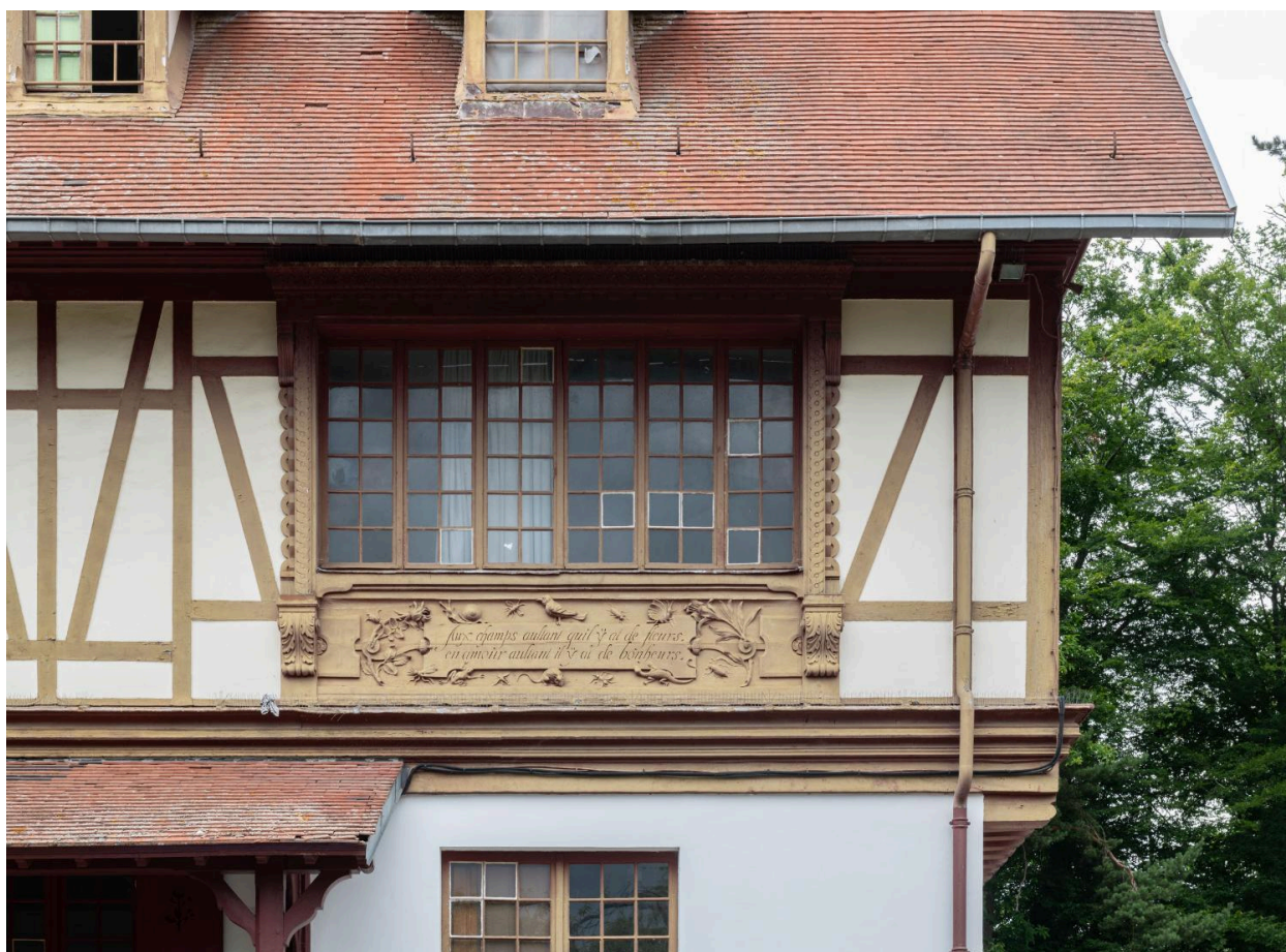
Détail de la façade est
